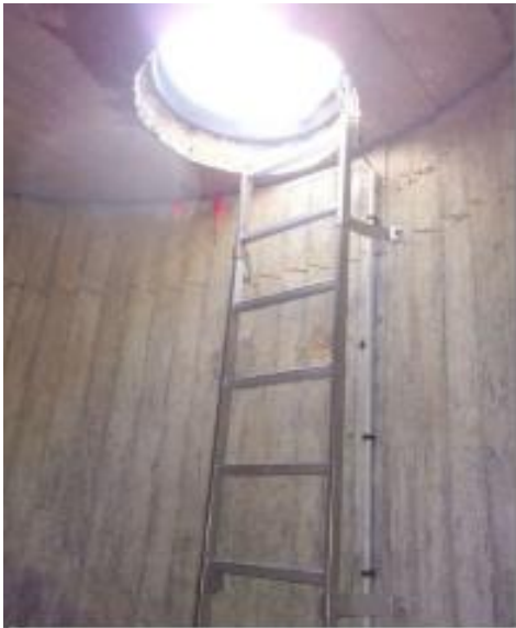
Photos de l'intérieure du Puits de Captage des Gravières à Pont du Château Profondeur de l'ouvrage : 7 m environ Pompage dans la nappe alluviale de l'Allier
