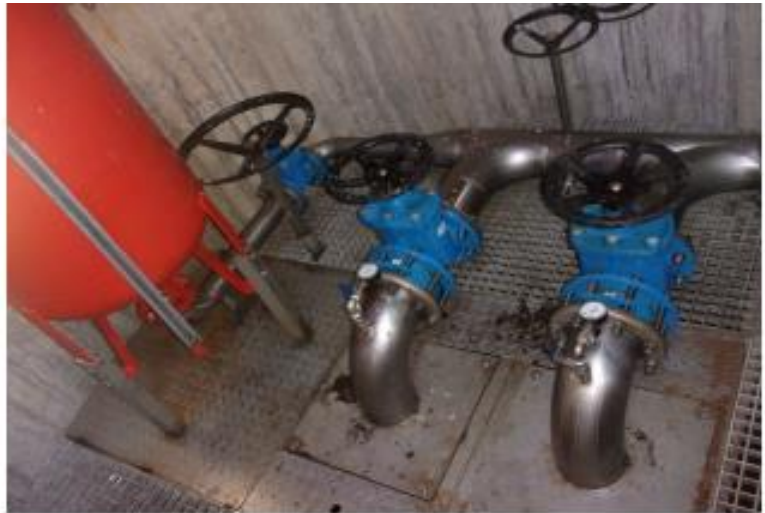
Photos de l'intérieure du Puits de Captage des Gravières à Pont du Château Profondeur de l'ouvrage : 7 m environ Pompage dans la nappe alluviale de l'Allier
