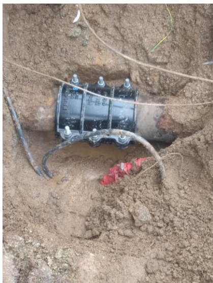
Photo d'un manchon de réparation
